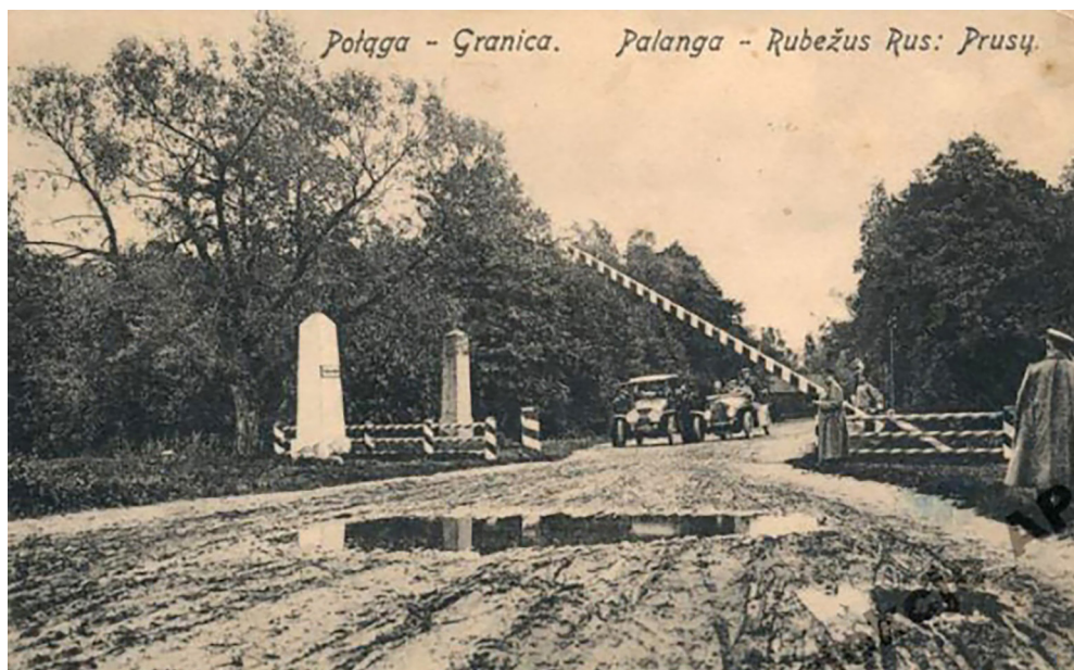
Sienas perėjimo punktas ties Palanga. Kairėje – Rusijos sienos stulpas 370, už jo tolėliau – Prūsijos sienos stulpas 380
