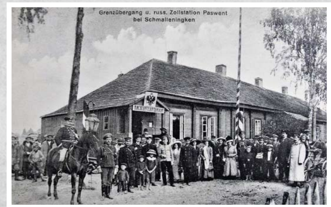
53. 'Sienos perėjimo punktas ir Rusijos muitinė Pašventyje ties Smalininkais.'
