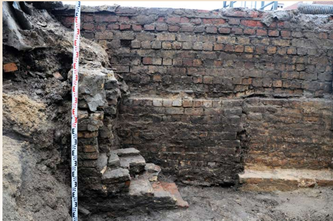
8. Užmūryta įėjimo į slėptuvę anga iš vidinės atraminės sienos pusės. D. Baltramiejūnaitės nuotr.
